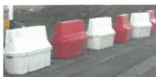
Durcir les obstacles en les remplissant avec du béton et / ou du sable
