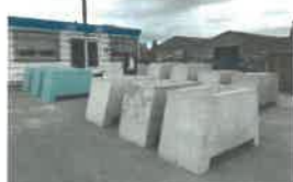
Jardinière anti-bélier (renfort par support béton)
