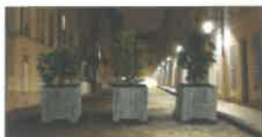
Jardinière anti-bélier (renfort par support béton)
